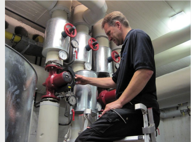
Hausmeister Timmy Schrader baut eine Hocheffizienz-Umwälzpumpe ein
