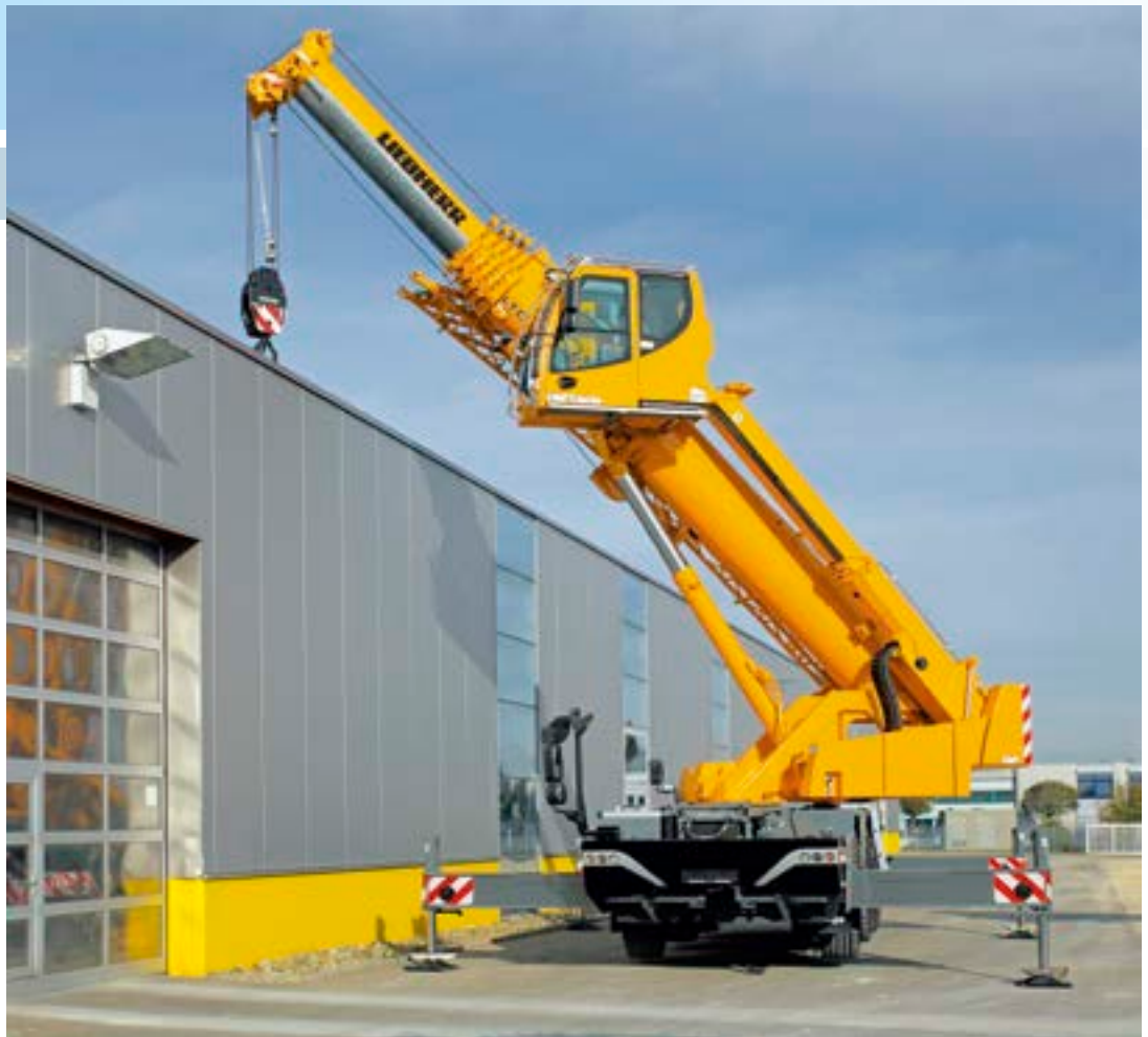
Tries-Technik im Einsatz
