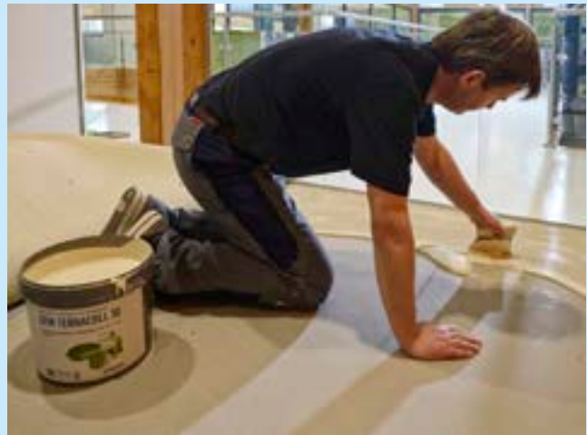
Typische Anwendung - Aufbringen eines lösemittelfreien Textilbelagsklebstoffs
